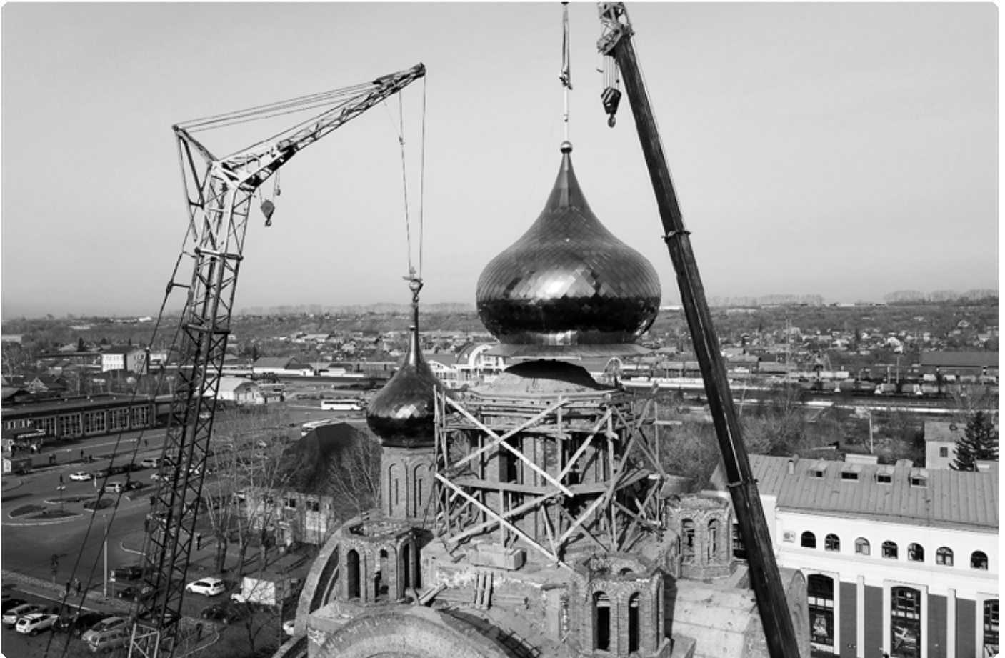
Установка центрального купола с крестом. г. Бийск. 26 октября 2021 г. Фото Сергея Доровских
